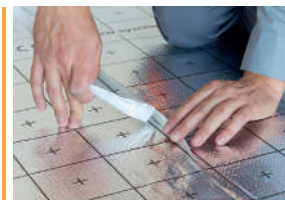
Solapa autoadhesiva con cinta protectora.
