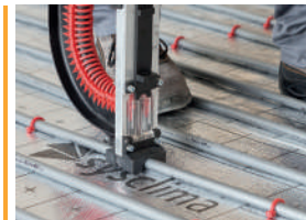
Cómoda colocación del tubo con grapa 3D.
