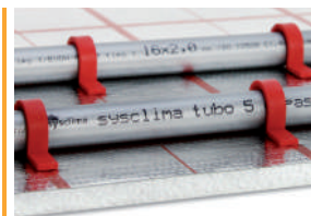
Colocación de tubo con grapa PS 10/16.
