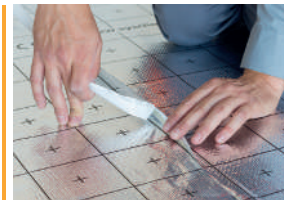
Solapa autoadhesiva con cinta protectora.
