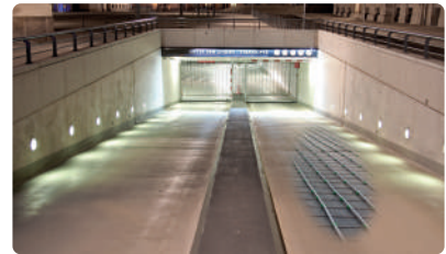
Rampa de acceso a garaje calefactada.
