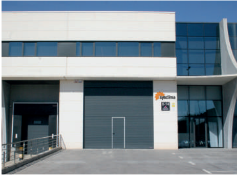
Oficinas centrales y almacén logístico. [SYSCLIMA]
