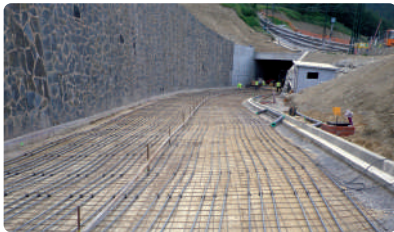
Entrada a túnel en el Pirineo.
