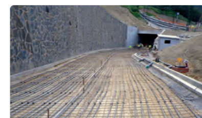
Entrada a túnel en el Pirineo.
