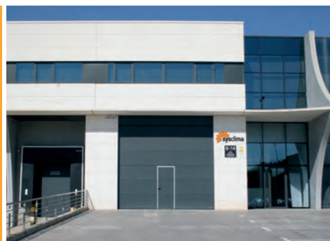
Oficinas centrales y almacén logístico. [SYSCLIMA]
