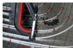
Fijación de tubo multicapa Sysclima mediante grapadora 3D profesional.
