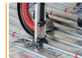
Cómoda colocación del tubo con grapa 3D.
